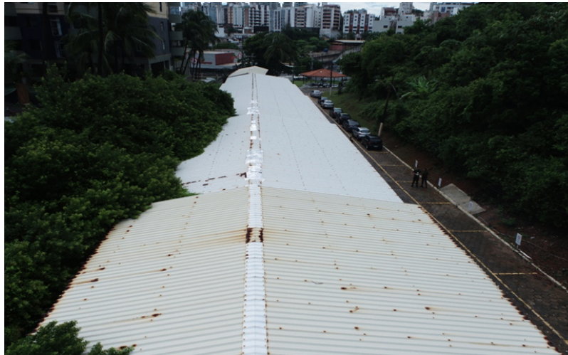
Foto 1 – telhas e cumeeira com elevado grau de corrosão.
