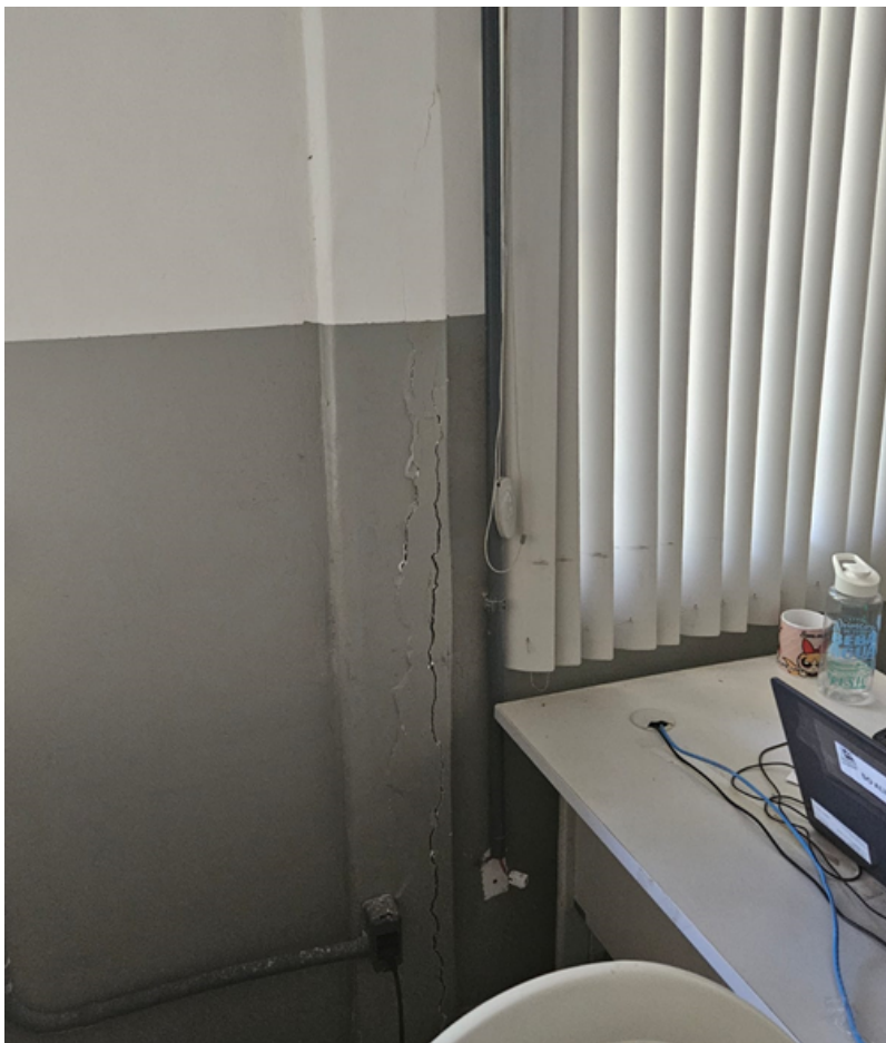
foto 5 – pilar com trinca no revestimento devido a provável oxidação da armadura.
