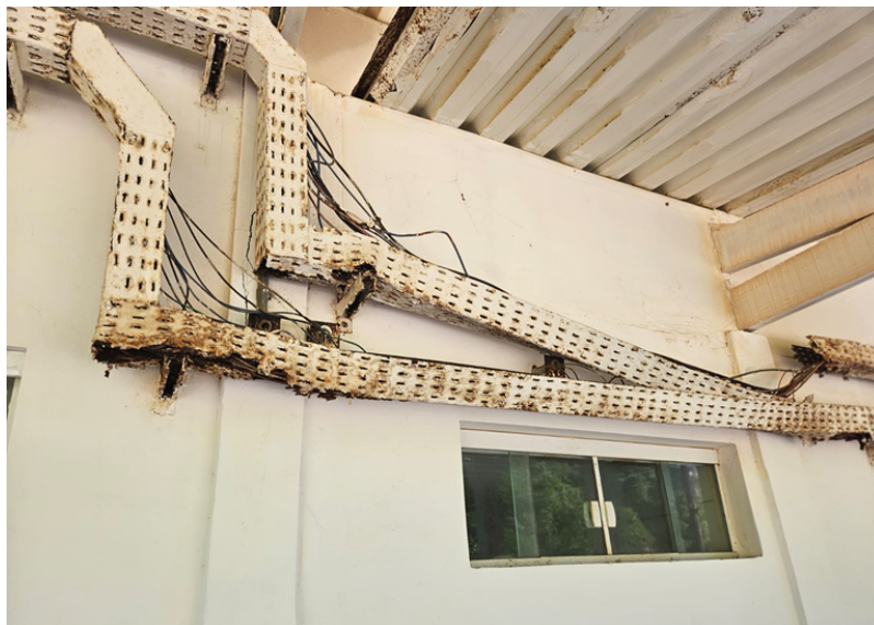
Foto 2 – infraestrutura elétrica deteriorada
